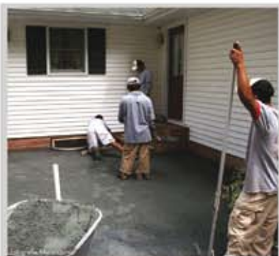
Salvadores trabajando en la construcción. CALIFORNIA, ESTADO UNIDOS.
